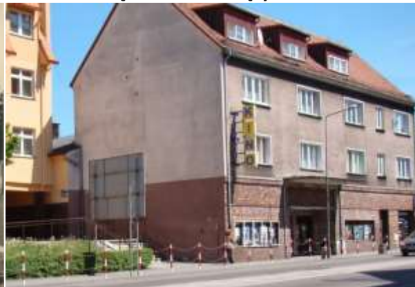
Fot. 8. Kino Tęcza - stan bieżący
