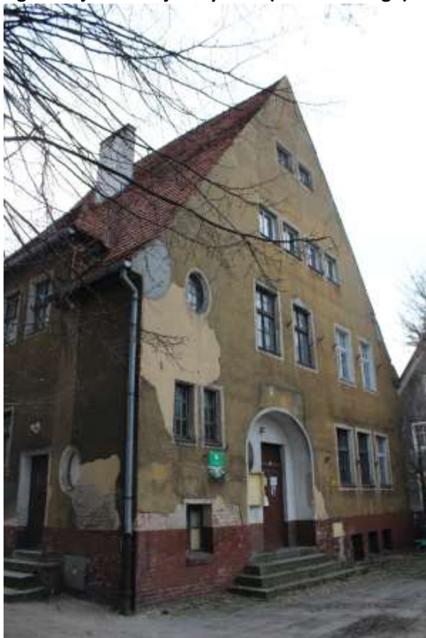
Fot. 2. Przykład degradacji technicznej budynków z gminnej ewidencji zabytków (ul. Okulickiego)
